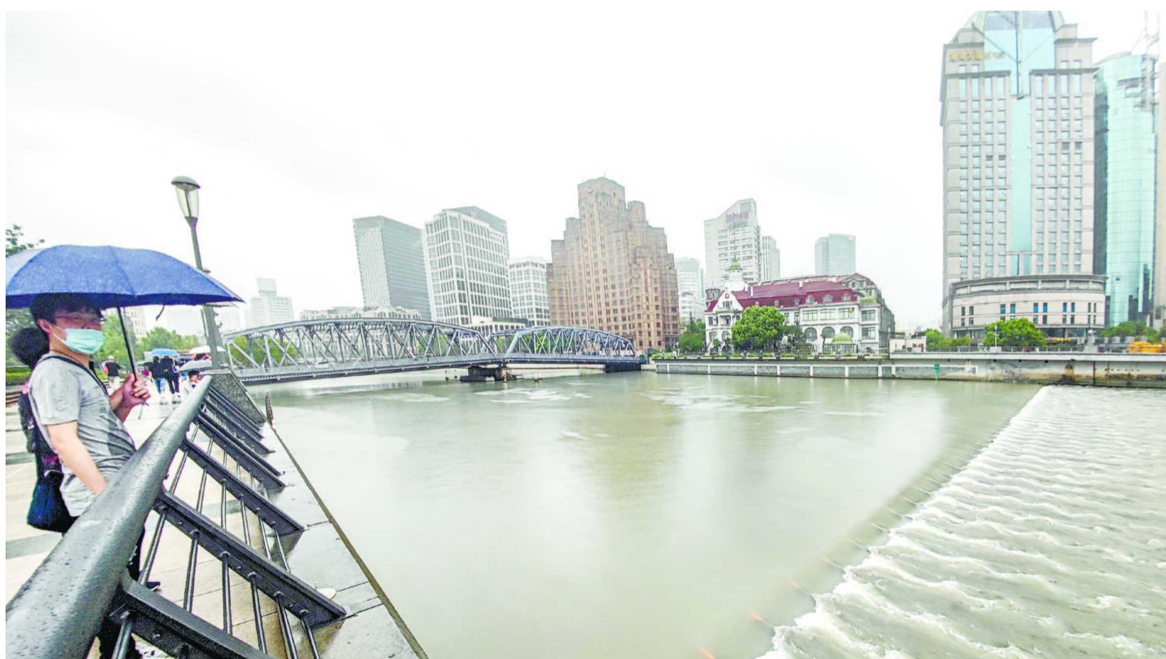
昨天下午,外白渡桥苏州河水位明显高于黄浦江水位,水面下起挡潮作用的闸门高度基本与河面齐平,闸门顶部河水溢出形成小梯度“瀑布”。
