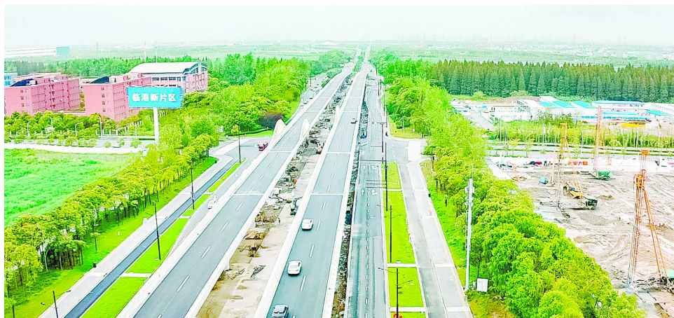
申港大道(随塘河西-沪城环路)改建工程昨日竣工通车
