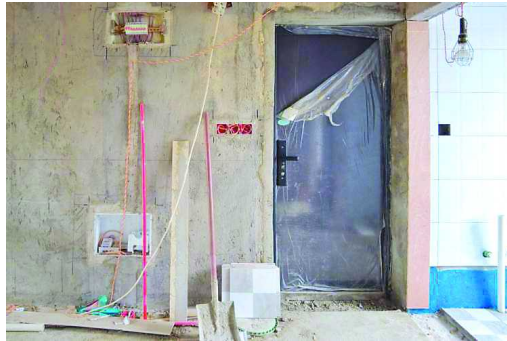
未完工的工地
