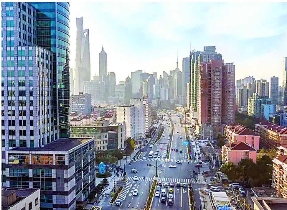
昨日,浦东大道地面道路全面通车。
