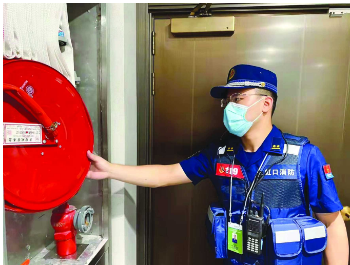
消防监督员检查消防设施
