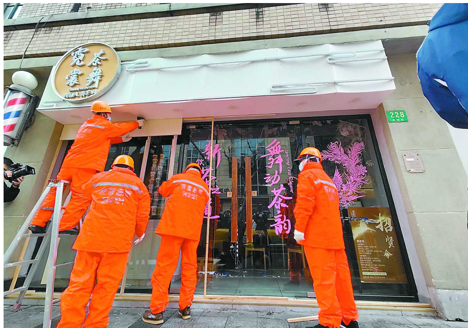
装在愚园路228号奶茶店的木板被迅速拆除，露出了玻璃门。 /见习记者 姚沁艺 实习生 胡越魁
