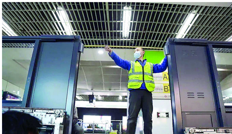
工作人员安装新安全门
