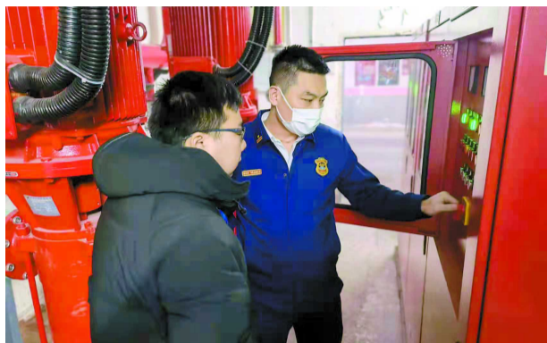
瘫痪的消防设施如今已更换完毕
