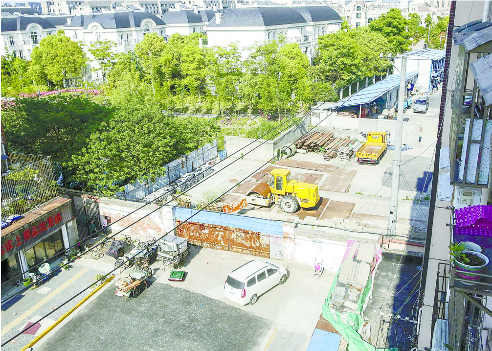
建在民府路上的一堵墙将两边隔成“断头路”,墙的一侧被一家建筑公司圈出一个院子。 /晨报记者 张佳琪
