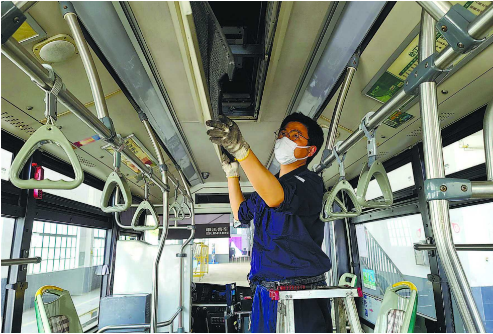
维修人员拆卸空调滤网
