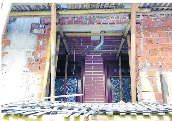
业主在原房屋外新砌出红砖墙
