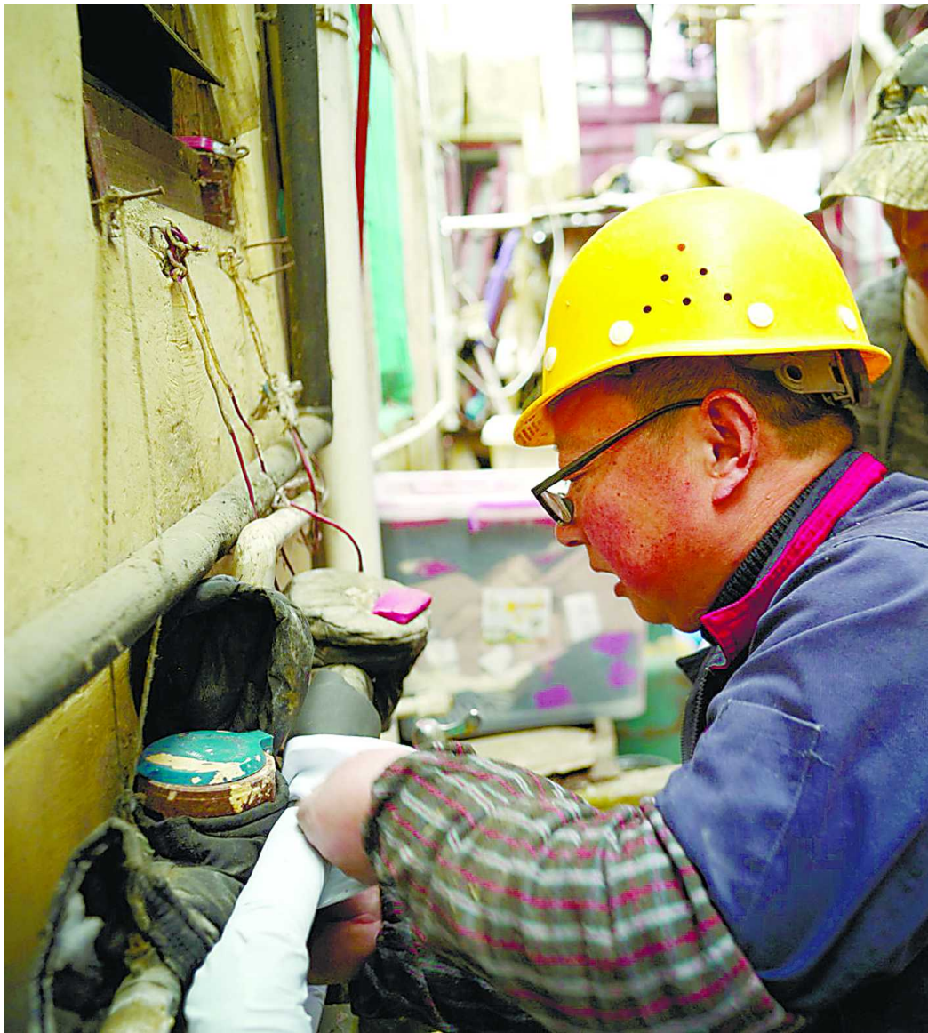
迎战低温寒潮！昨天，在黄浦区老城厢四牌楼路，俞洪飞师傅正在给自来水管穿“棉衣”。
