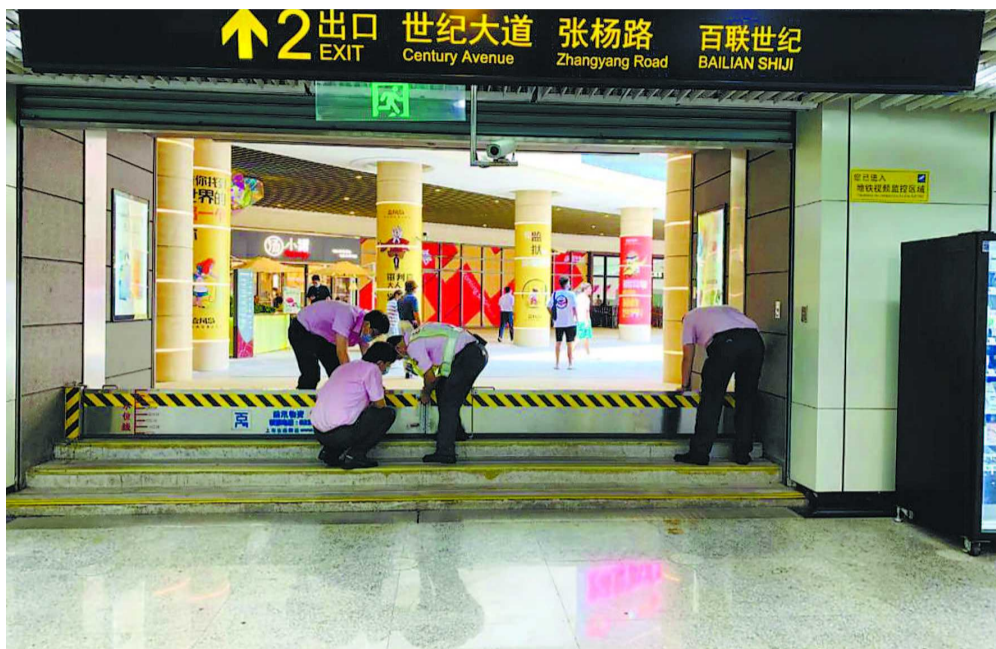
上海地铁工作人员在检查防汛设备
