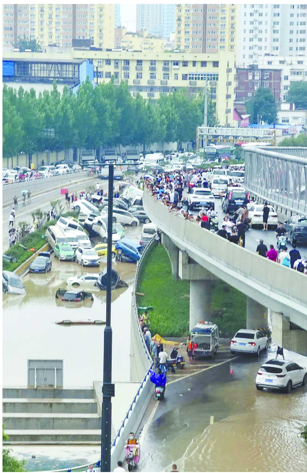
郑州市京广路立交桥下很多车辆泡在水中
