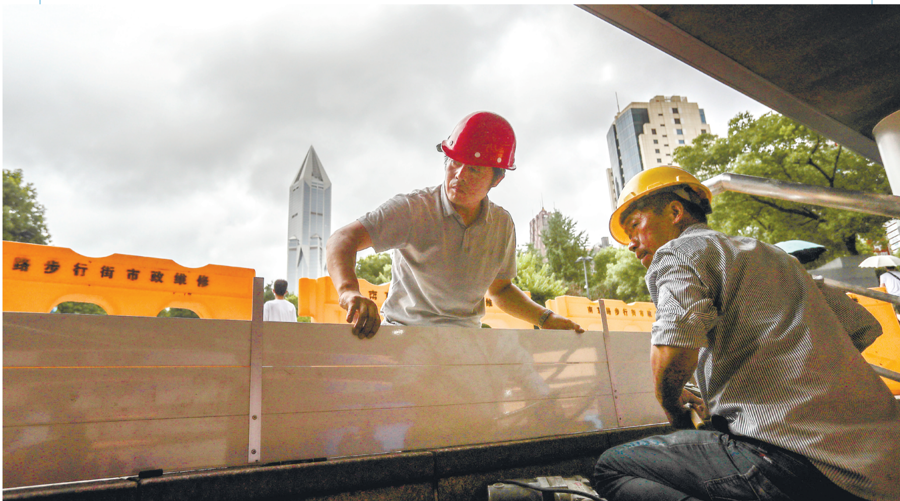
昨日,施工人员在南京西路西藏中路地铁人民广场站下沉广场地下通道口安装挡水板。
