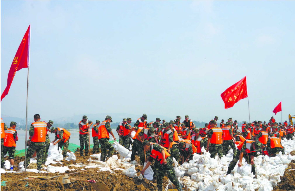
武警河南总队某支队官兵在新乡市卫河河堤上装填沙袋
