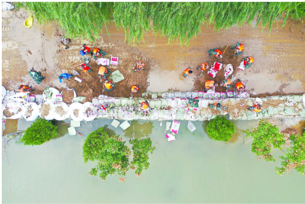
在山西省河津市阳村街道连伯村,抢险人员在加固临时堤坝(10月10日摄,无人机照片)。
