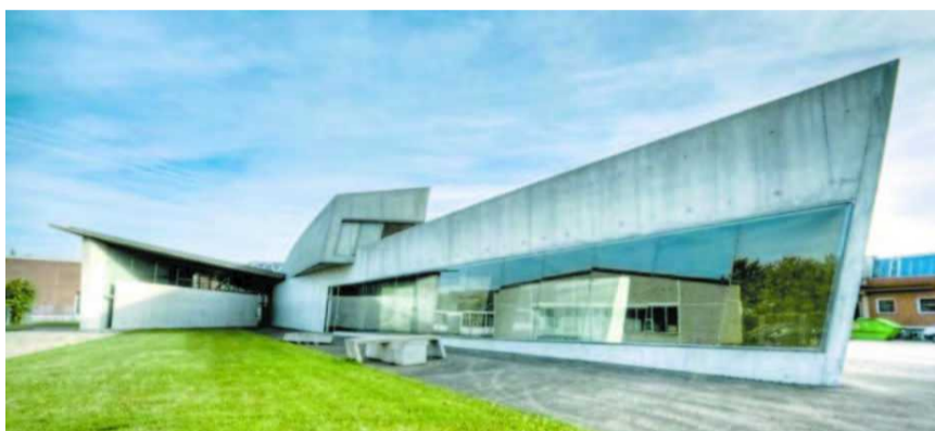
维特拉消防站
