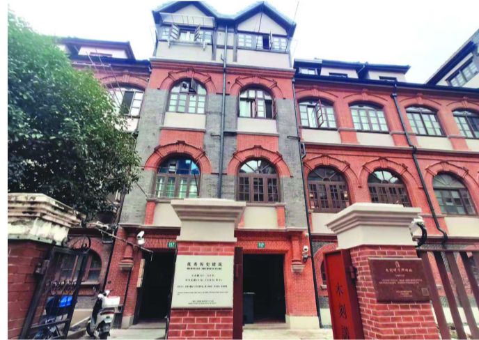
完成修缮的木刻讲习所
