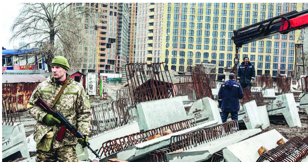
3月2日，基辅，士兵与工人正在修筑防御工事。
