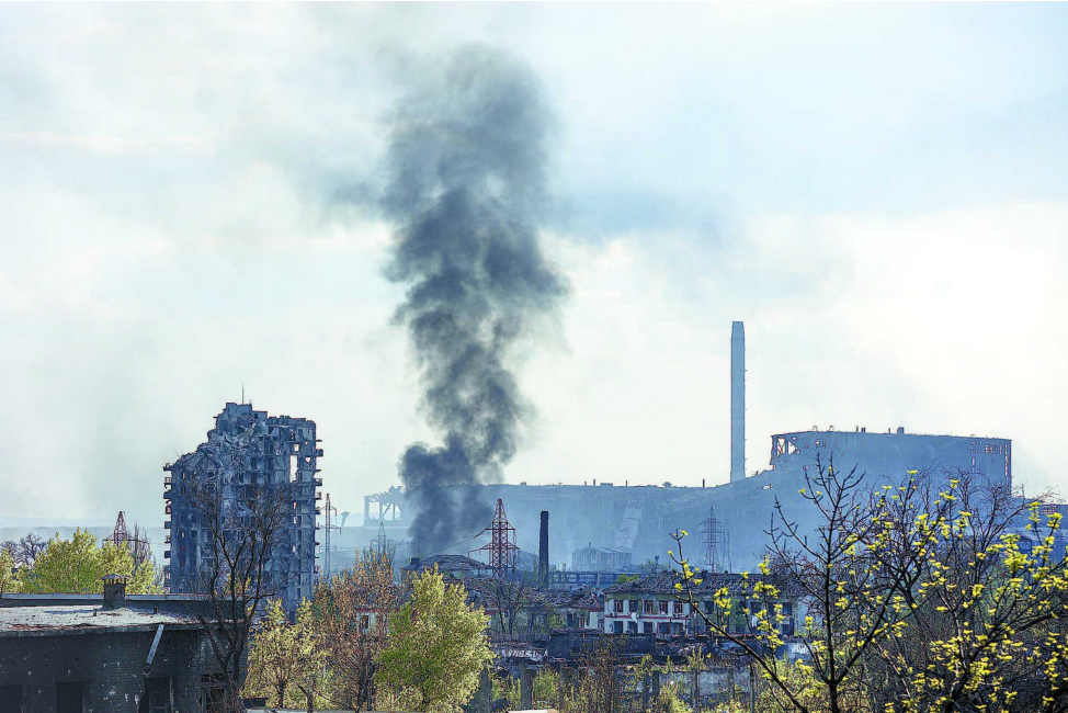
5月4日,顿涅茨克地区马里乌波尔,亚速钢铁厂中冒出浓烟。/人民视觉
