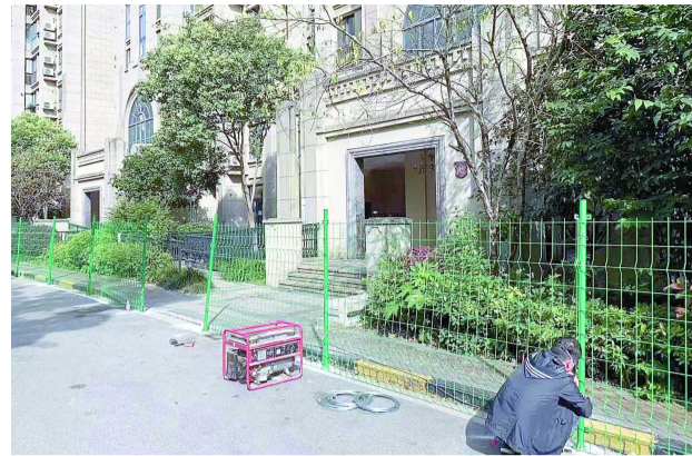
施工人员在打洞，再用铁丝网将楼栋围住。/见习记者 姚沁艺
