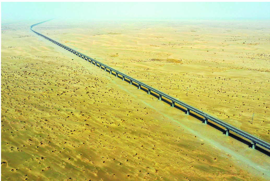
5月19日拍摄的和若铁路依木拉克特大桥(无人机照片)。
