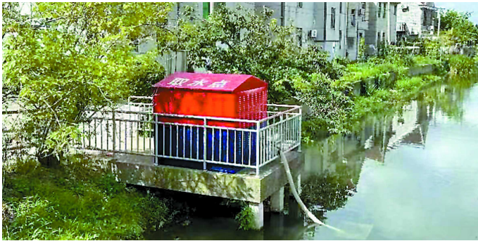
康桥镇因地制宜建设取水码头 /消防供图
