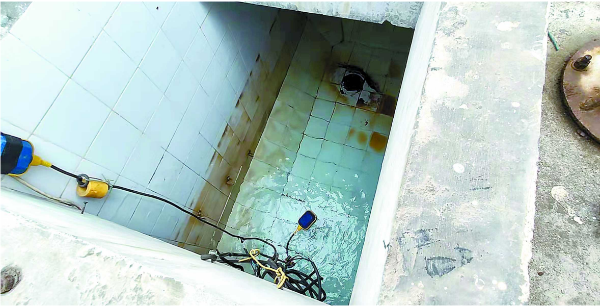
一期楼栋顶楼水箱底部附着深色物质,水中还有铁锈状固体。
