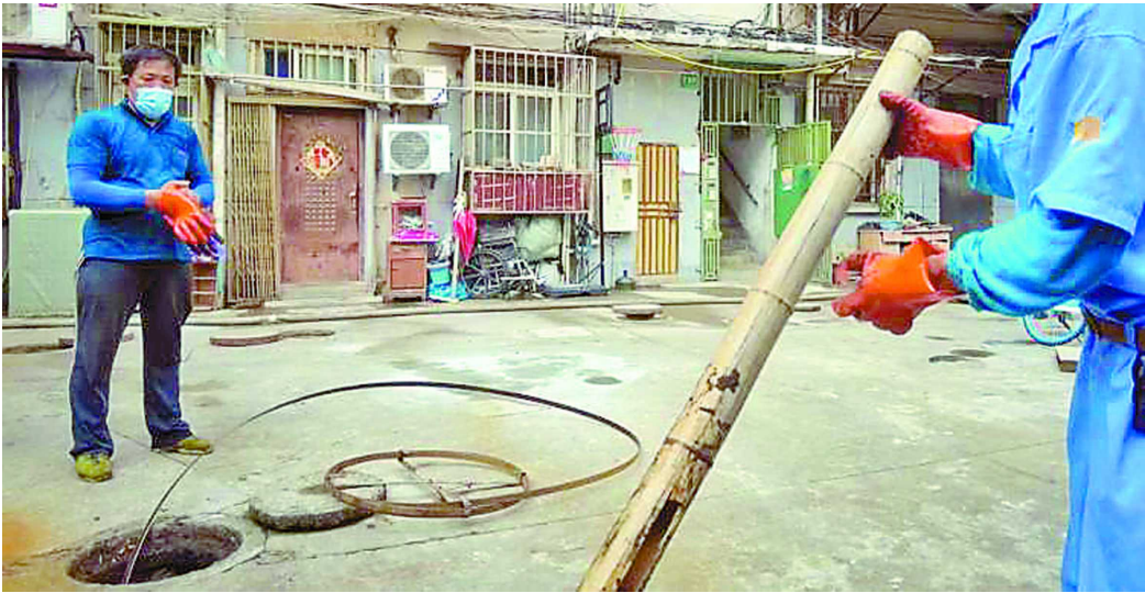
工作人员对管道进行疏通
