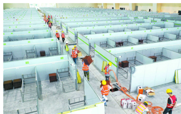
10日，工人在三亚第二方舱医院作业（无人机照片）。/新华社
