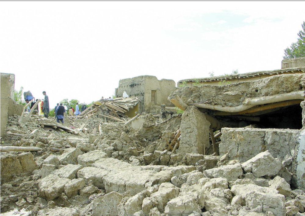
8月21日,阿富汗民众查看在洪水中坍塌的房屋。/人民视觉
