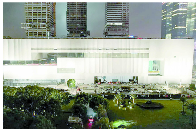
新建上海博物馆东馆亮灯调试 /上海建工
