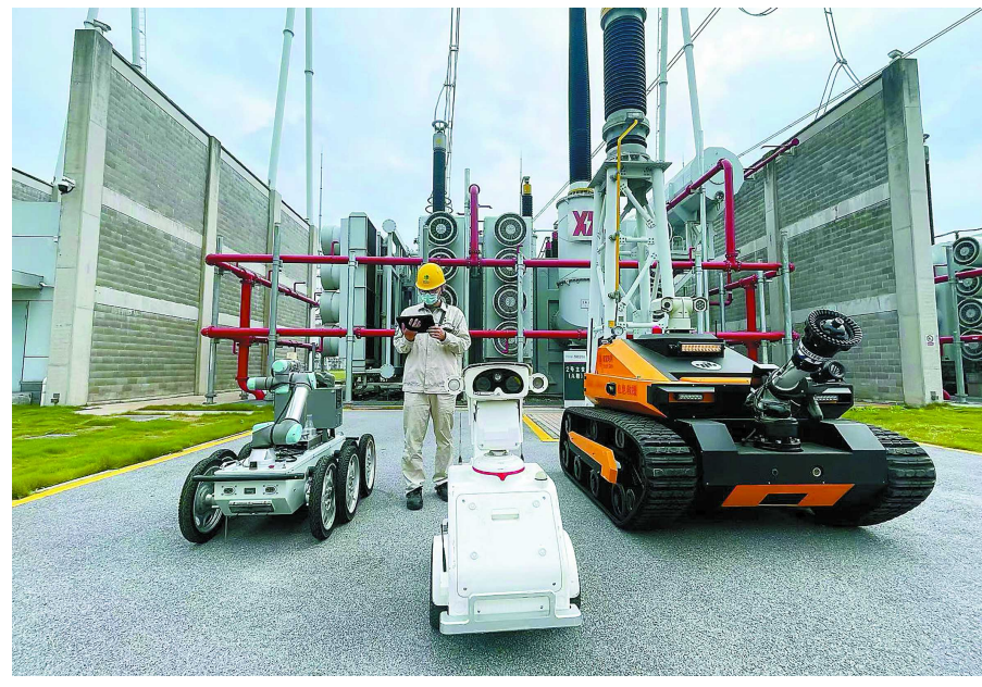
国网上海电力应用先进装备,提升进博期间主站点安全运行可靠性。 /受访者供图
