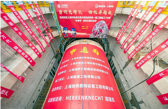
崇明线“申通号”超大盾构在长兴岛大小盾构转换段顺利完成始发 /上海地铁
