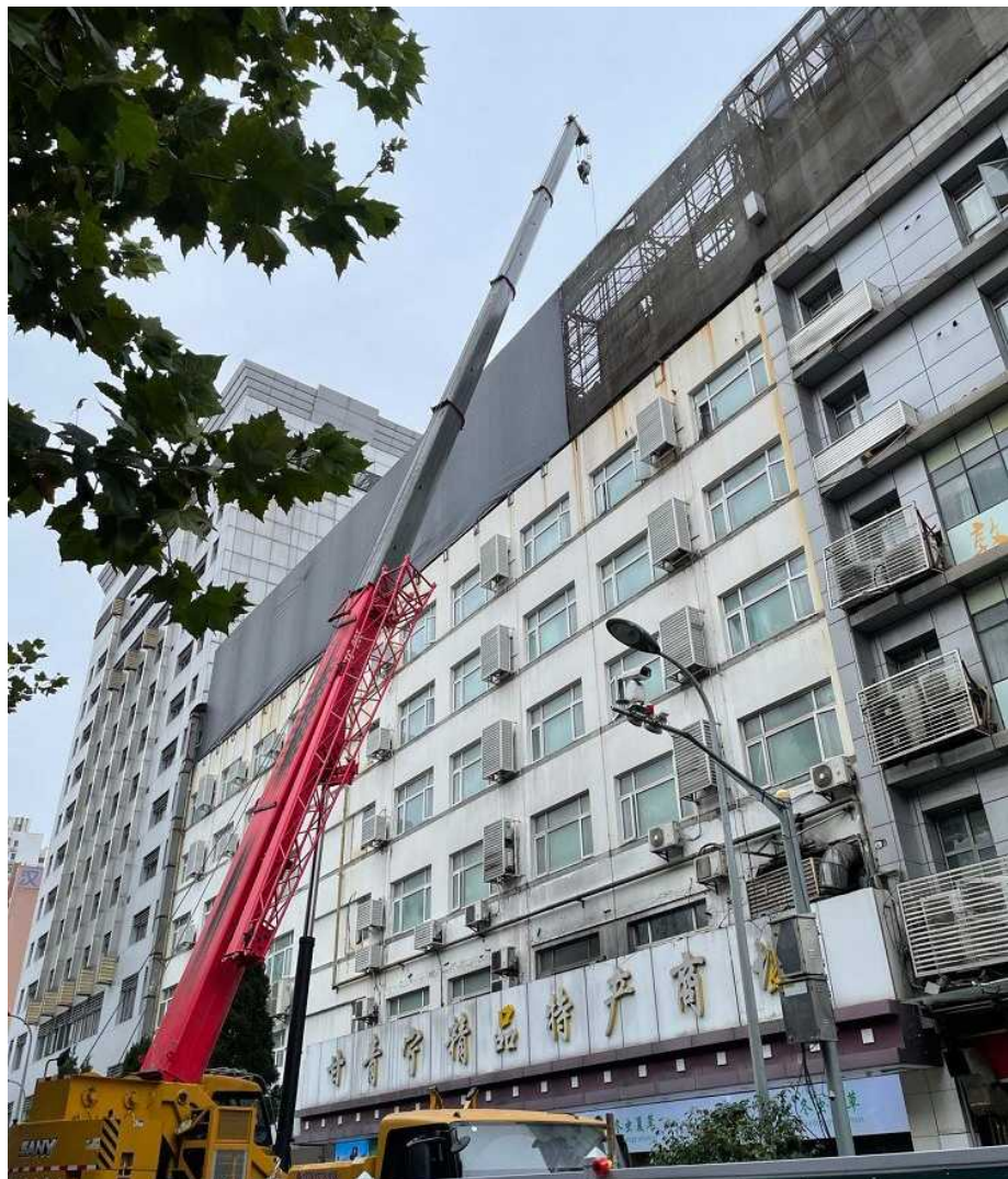
在镇坪路地铁站边隐藏了十多年的空中违建被拆除
