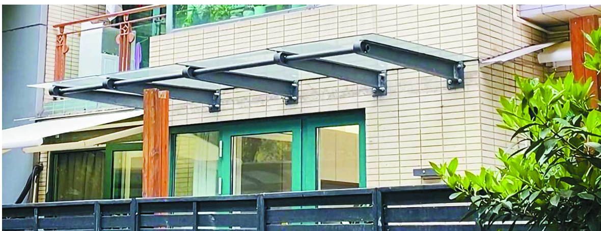
一楼居民违法搭建的玻璃顶棚
