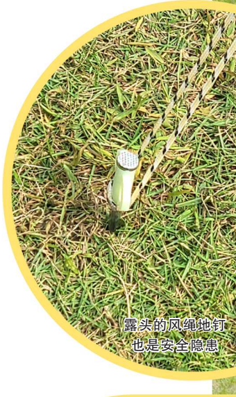
“露头”的地钉 存在安全隐患
