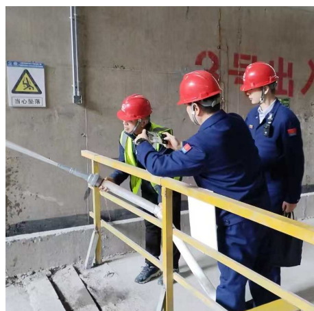
轨道交通深入在建工地,把好消防产品入口关
