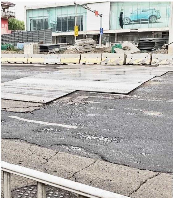
凹凸不平的路面上铺设了钢板
