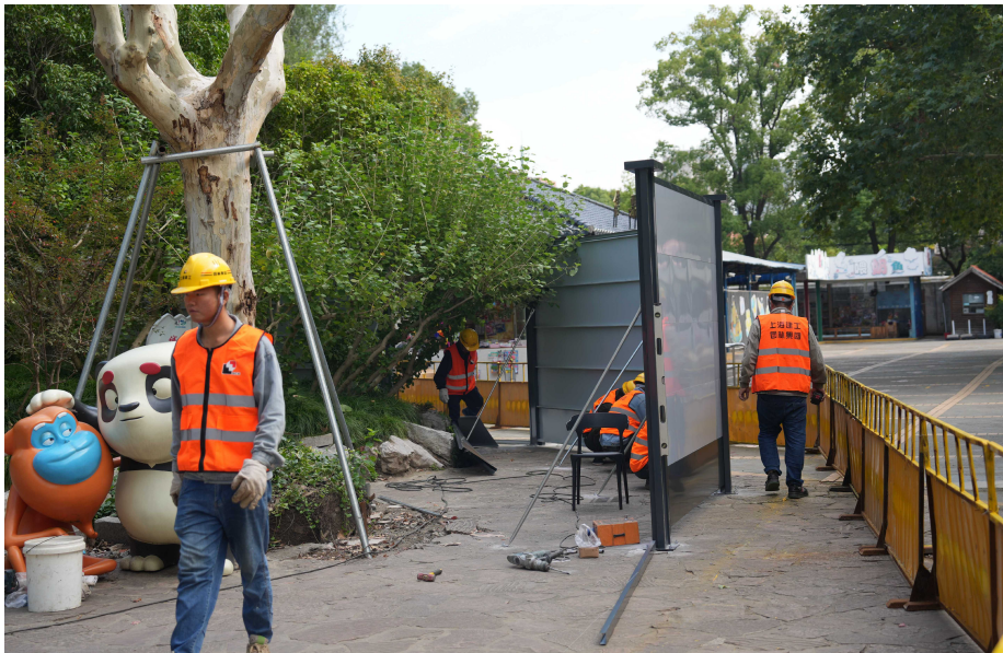
工人在做闭园施工的准备 (王笛/摄)
