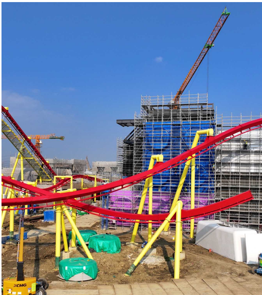
上海乐高乐园游乐设施施工现场图
