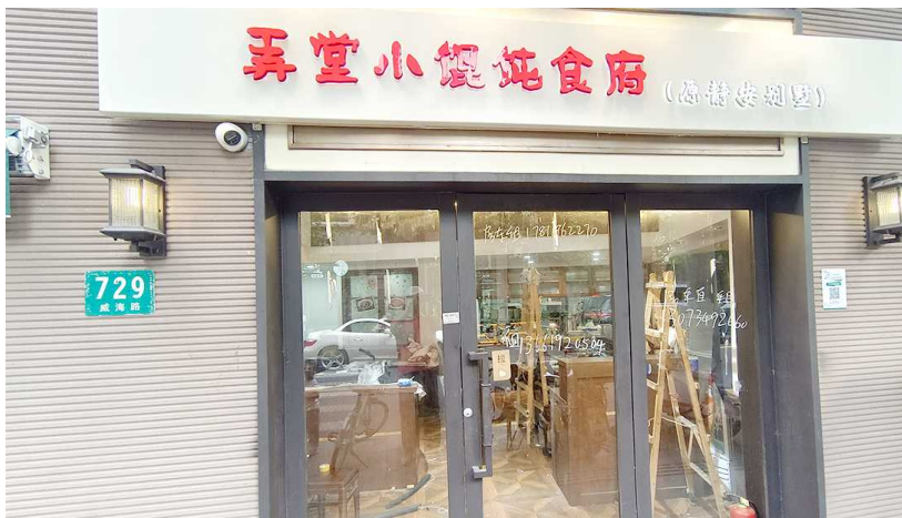
正在装修当中的新店(2025年6月24日拍摄)
