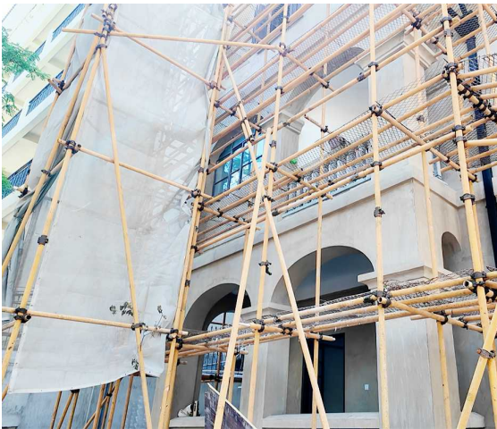
花园洋房还在施工中
